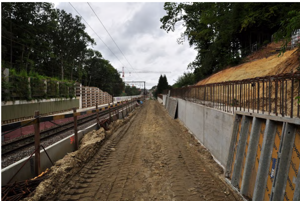
Figuur 48: Voorbeeld van de plaatsing van een steunmuur in Rixensart voor de aanleg van de GEN-sporen (Rail-be.net)
