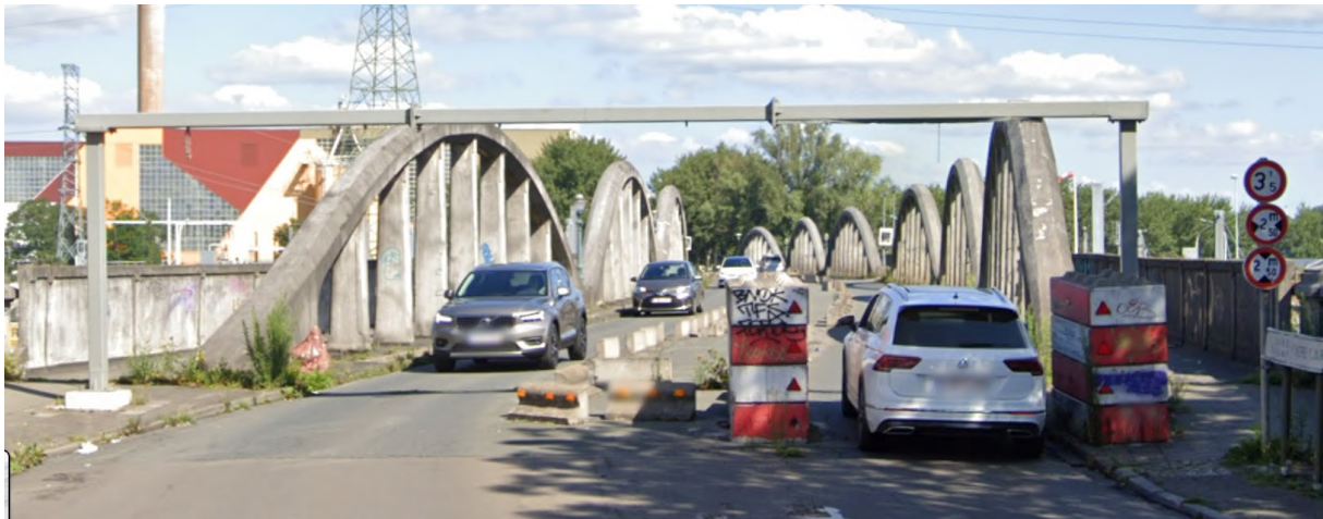
Figuur 46: Aanzicht op de toegang tot de brug vanuit Schaarbeek naar de haven (Googlestreetview, juli 2020)
