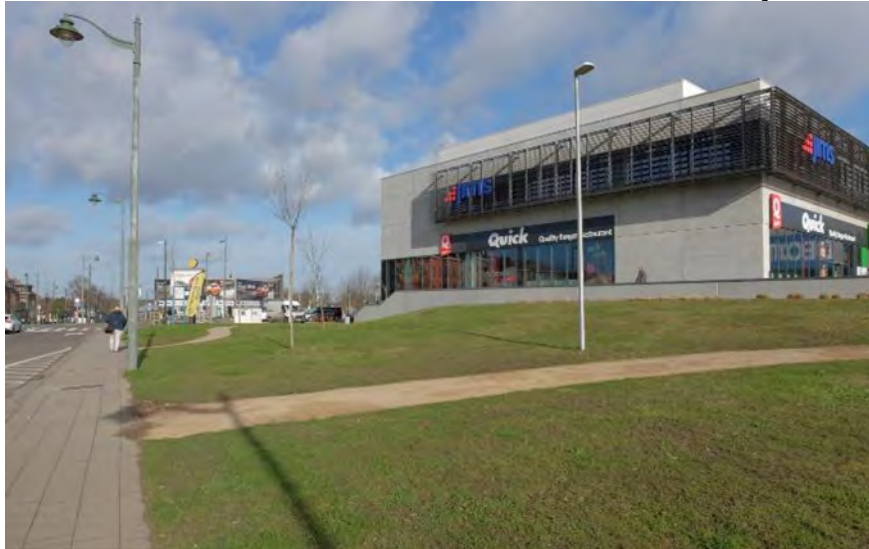
Figuur 122: Terrein rond het commerciële gebouw (ARIES, 2020)
