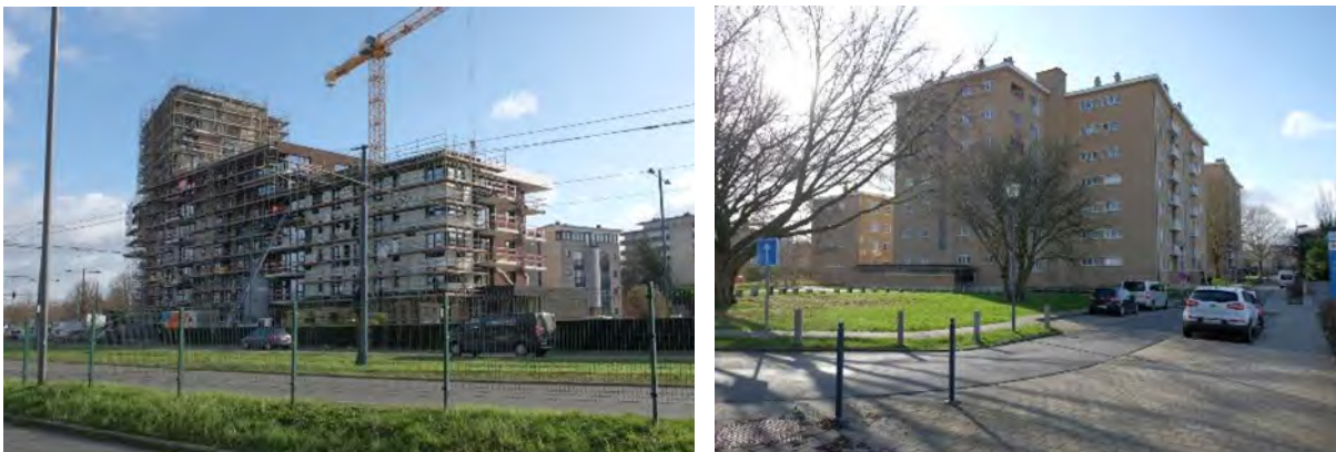
Figuur 111: Niet-opeenvolgende woongebouwen langs de Leopold III-laan (ARIES, 2020)
