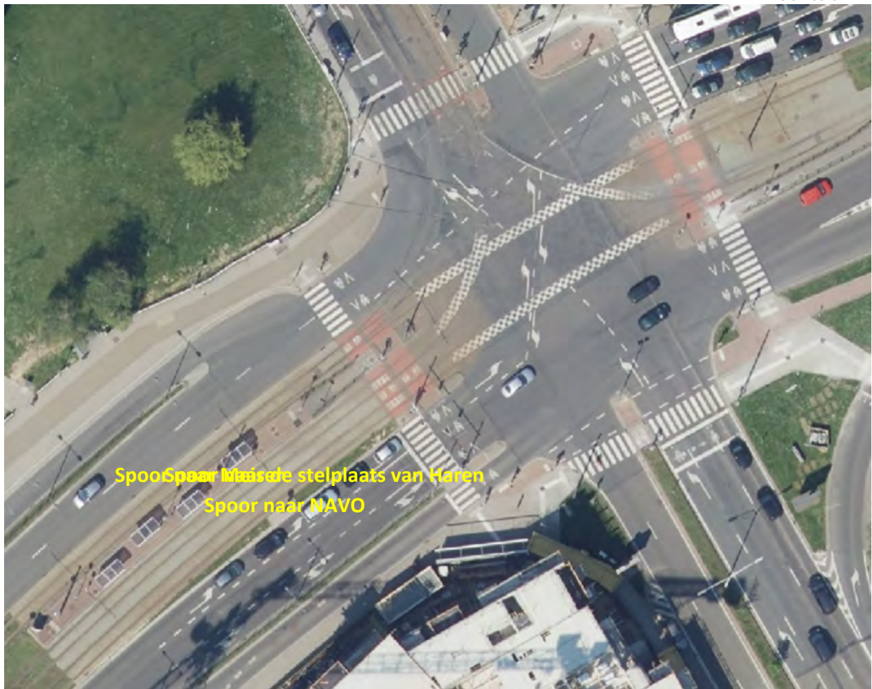
Figuur 77: Illustratie van de drie bestaande sporen op de Leopold III-laan (ARIES op BruGIS-achtergrond, 2020)
