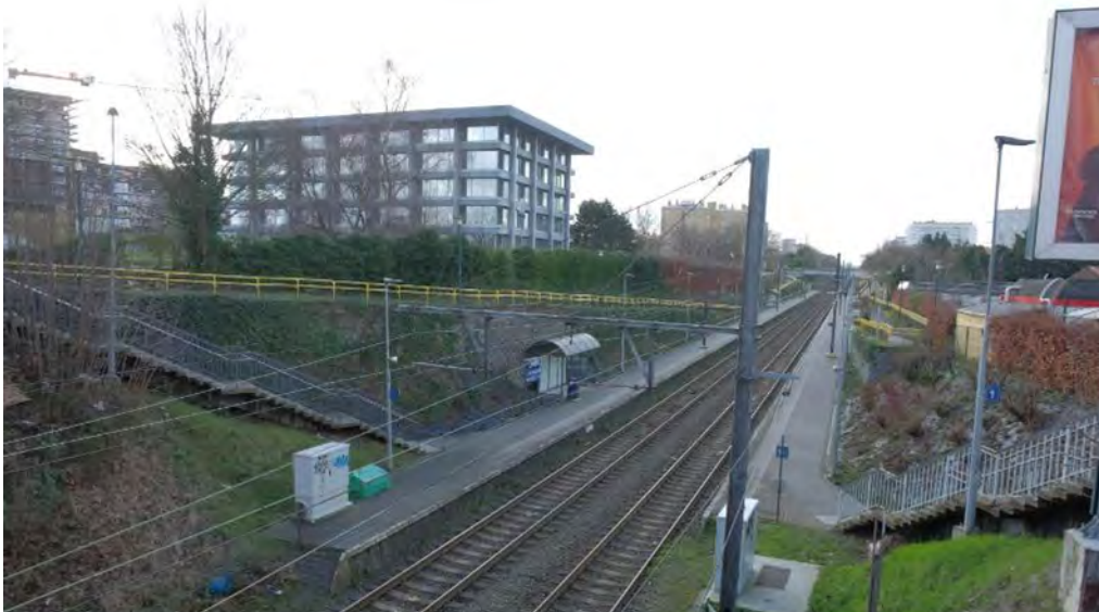
Figuur 1: Aanzicht van het station Bordet in de bestaande situatie (ARIES, 2020)
