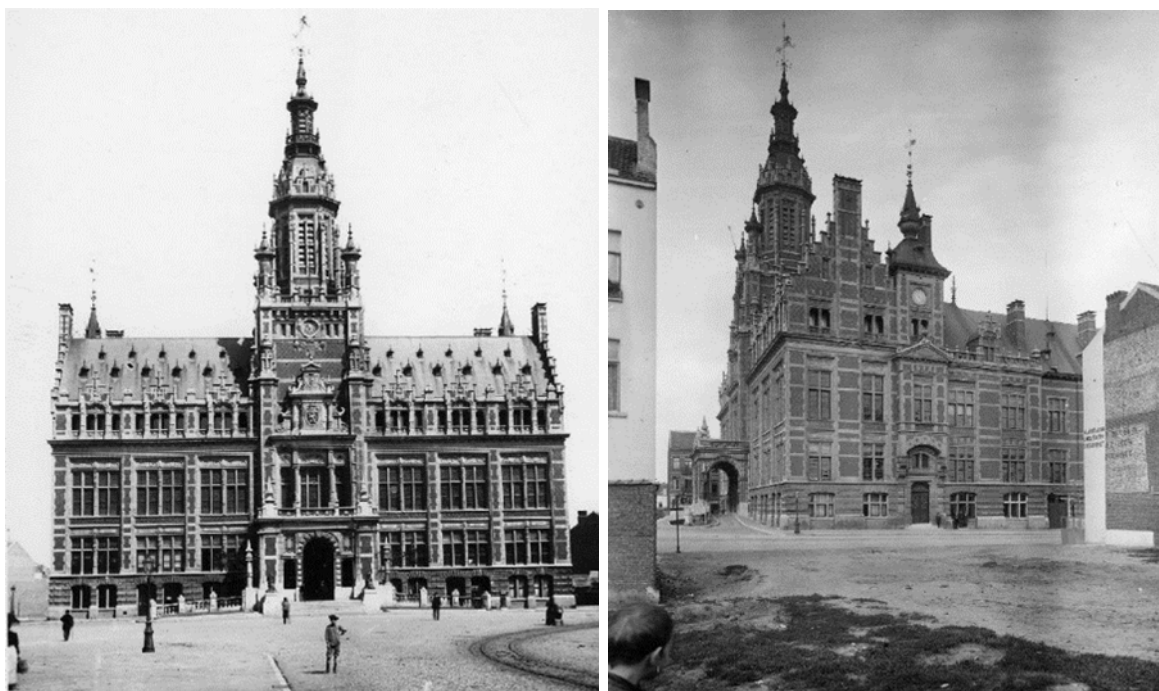
Figuur 84: Aanzicht van het Colignonplein in 1900 (links), aanzicht van het Colignonplein in 1895 (rechts) (uittreksels van Bruciel)
