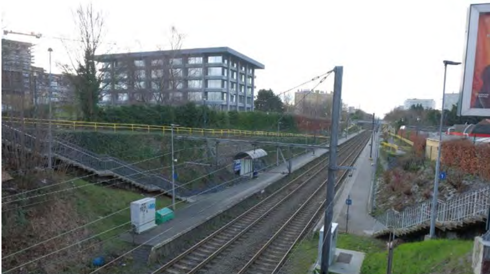
Figure 1 : Vue de la gare Bordet en situation existante (ARIES, 2020)
