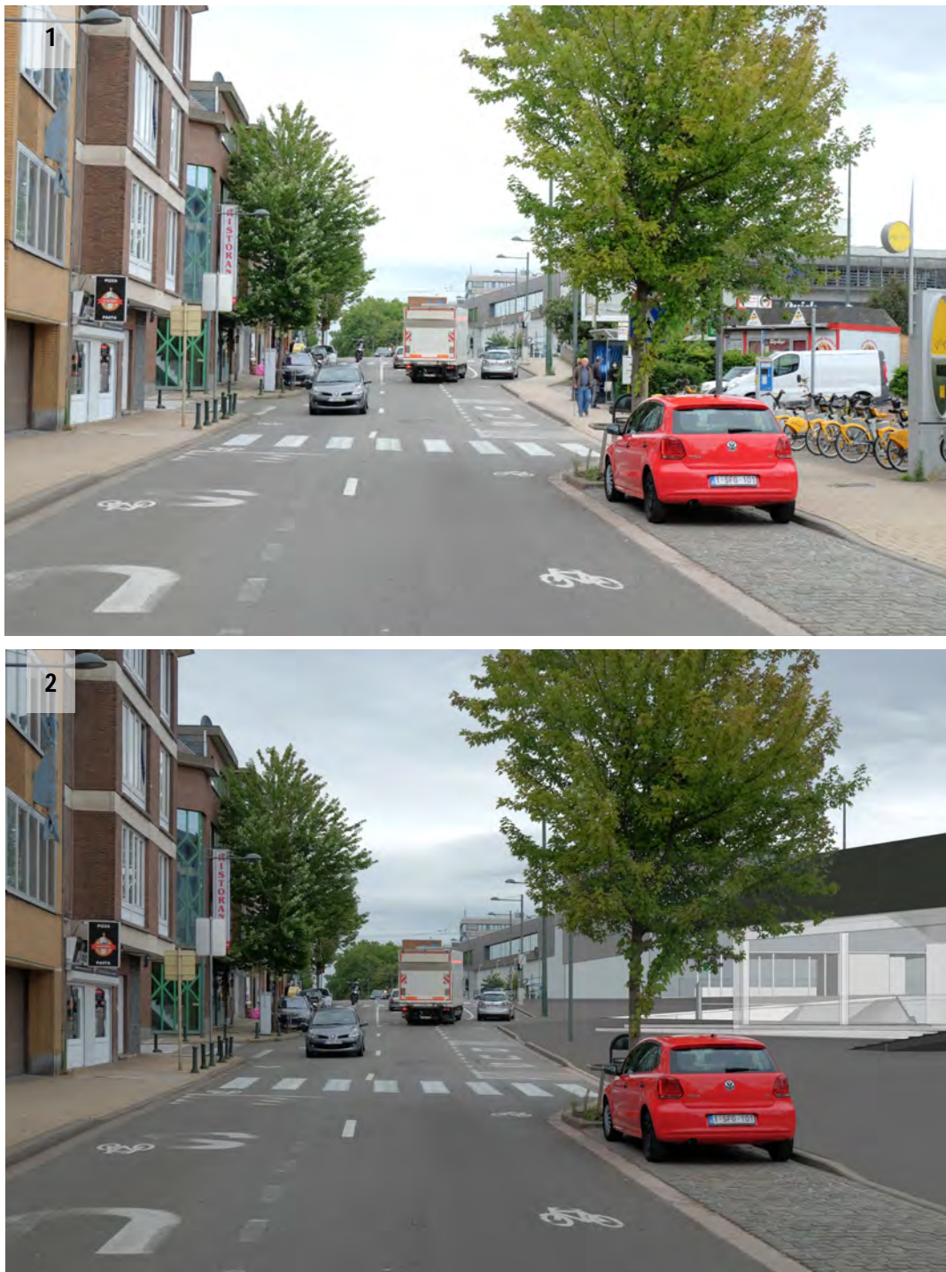
Figure 141 : Vue depuis la chaussée de Haecht : situation existante [1] et photomontage [2] (ARIES, 2020)
