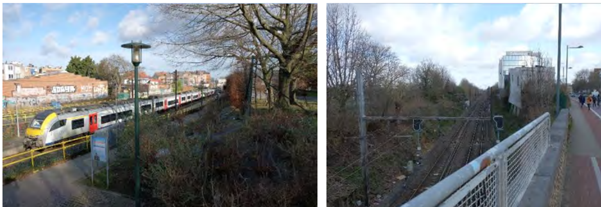
Figure 116 : Vues des voies ferrées au sud-ouest du site (à gauche) et au nord-est du site (à droite) (ARIES, 2020)
