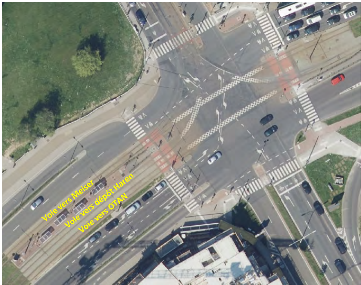
Figure 77 : Illustration des trois voies existantes sur le boulevard Léopold III (ARIES sur fond BruGIS, 2020)
