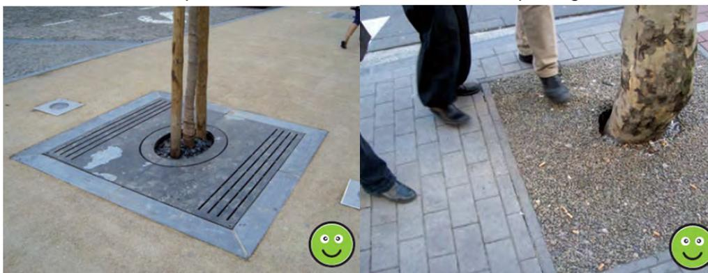
**Figure 96 : Aménagement des fosses de plantation préconisé pour les arbres repris dans la zone de quai du tram 7**
