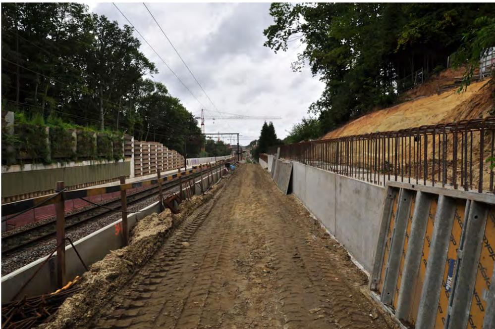
**Figure 48: Exemple de mise en place de soutènement à Rixensart pour permettre la pose des voies RER (Rail-be.net)**
